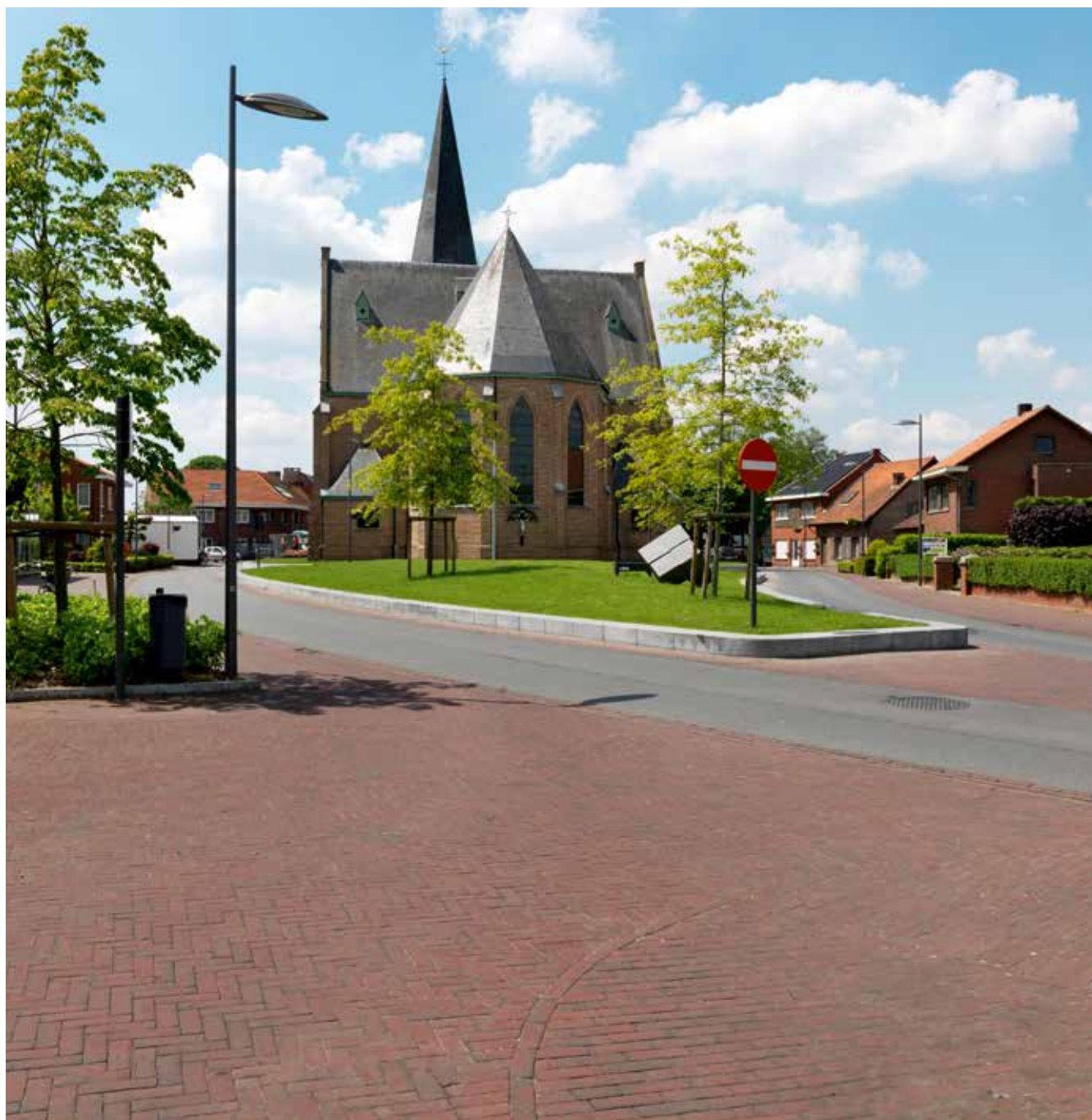
□ Rood-bruin gereduceerd | Arte Nieuwmoer, Kalmthout Architect: Bureau Omgeving, Berchem
